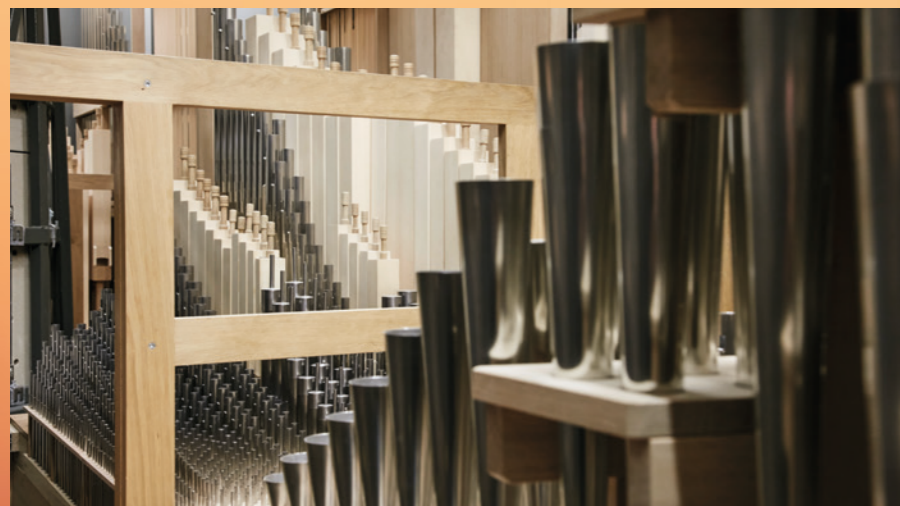
Die Orgel der Elbphilharmonie befindet sich in, neben und hinter den terrassenförmig angeordneten Zuschauerhängen. Einige der 4765 Pfeifen sind sichtbar und berührbar im Raum angebracht, so dass sie mit einer speziellen Beschichtung vor den Berührungen des Publikums geschützt sind. (Elbphilharmonie Maxim Schulz)
