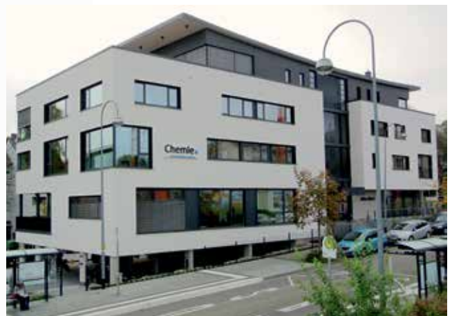
Umzug: Das neue Haus der Chemieverbände an der Allee Cité in Baden-Baden.
